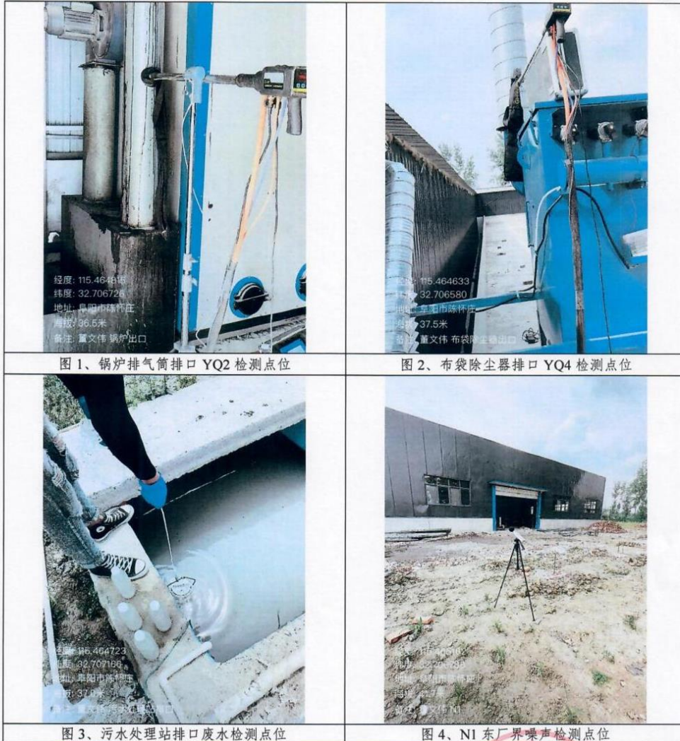
附图：2、现场检测照片
