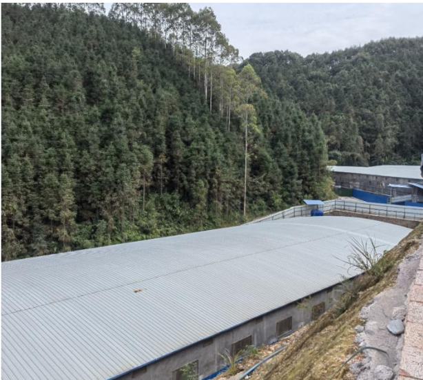
现有工程用地现状
