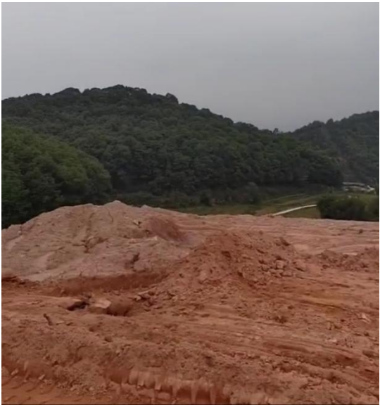
改扩建项目用地现状
