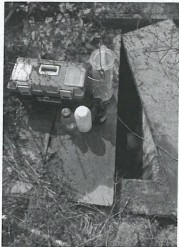
生活污水排放口
