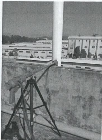
焊锡废气排放口
