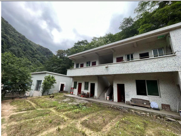
发电厂房全貌
