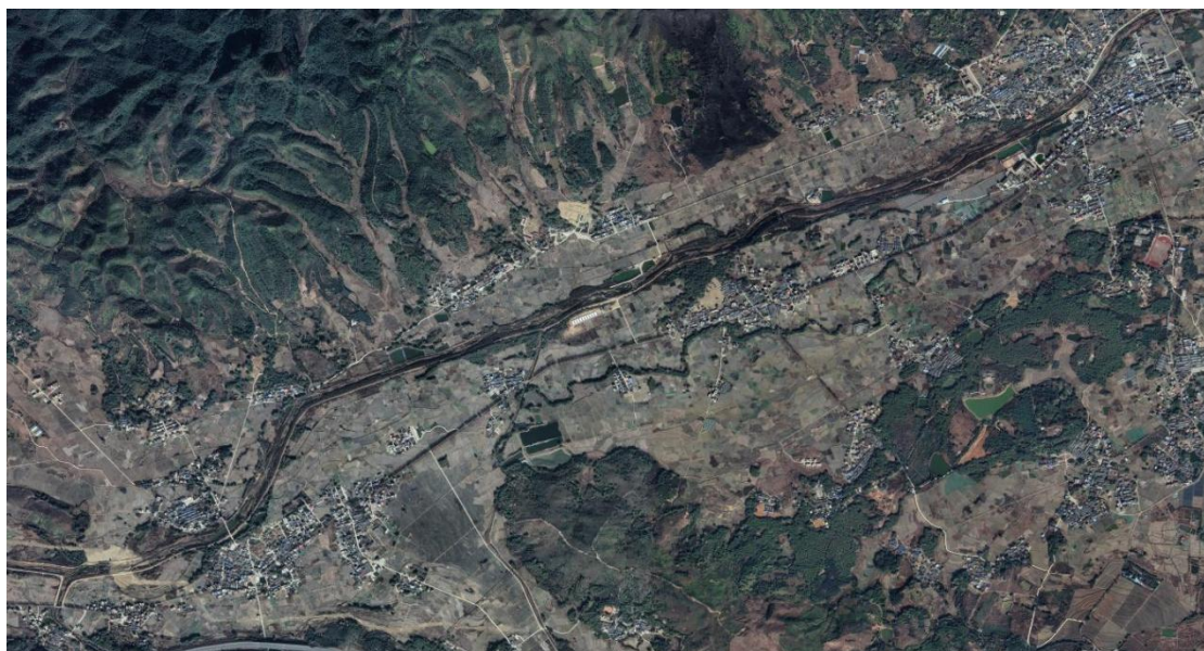
图 6.2-5d 沈所河沈所镇段影像图（2021 年）
