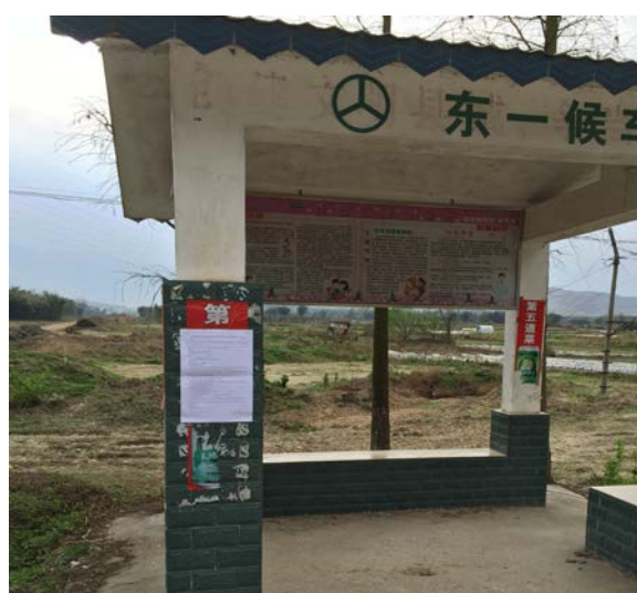
东一候车亭第二次公示（项目起点）
